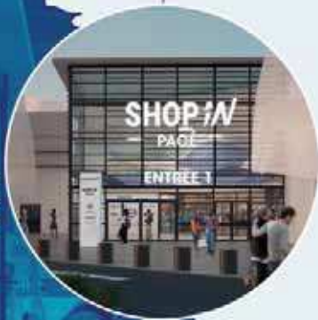
Extension-rénovation du centre commercial Rennes Pacé
